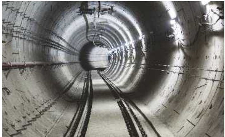
सचिवालय और हजरतगंज के बीच मेट्रो टनल के अंदर रिजिड ओवरहेड कंडक्टर सिस्टम (ROCS) का कार्य।
