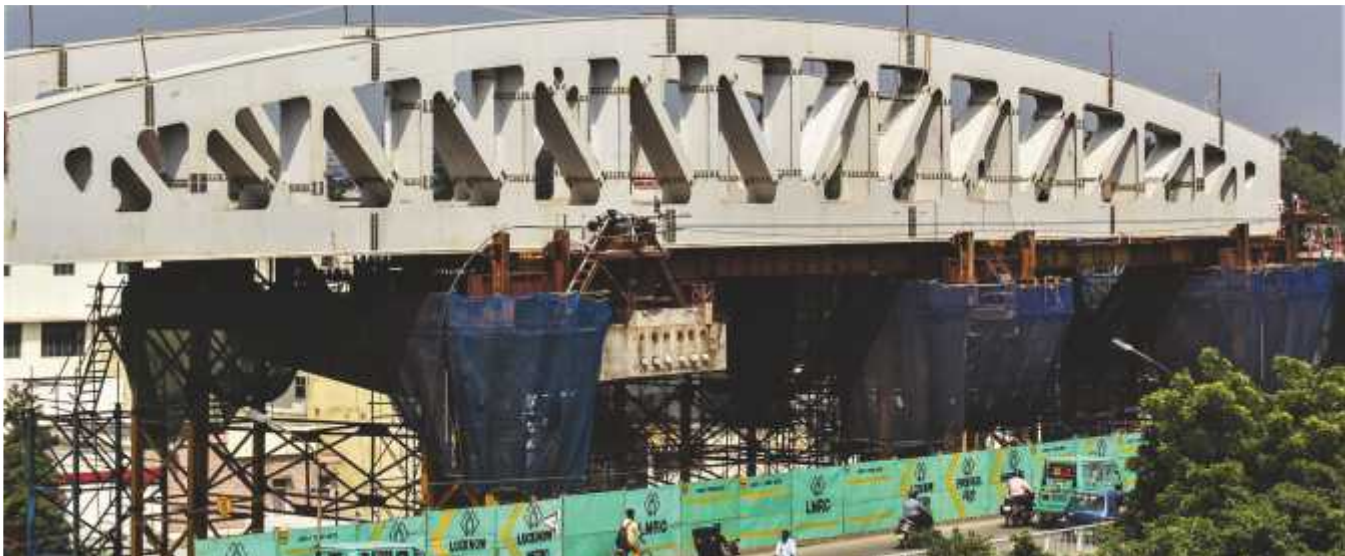
निशातगंज के पास रेलवे परिचालन ट्रैक मुख्य लाइन पर 60 मीटर के विशेष इस्पात स्पैन का निर्माण
